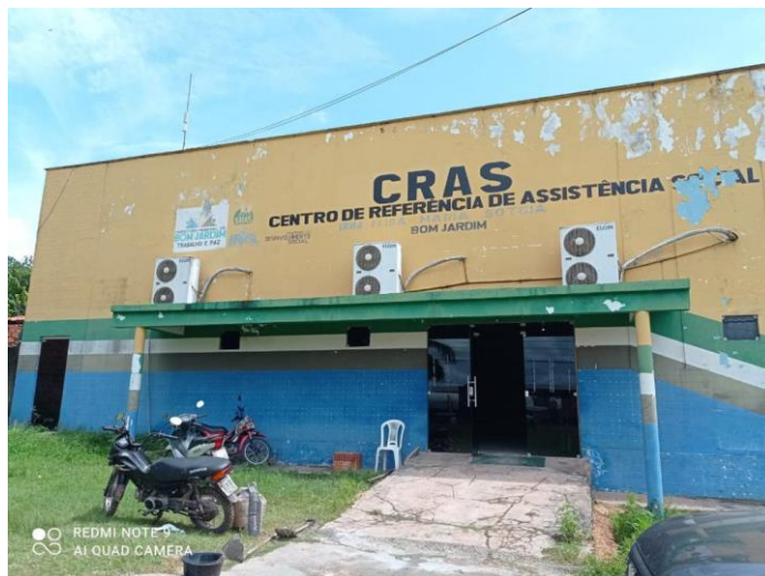
Fachada do prédio
